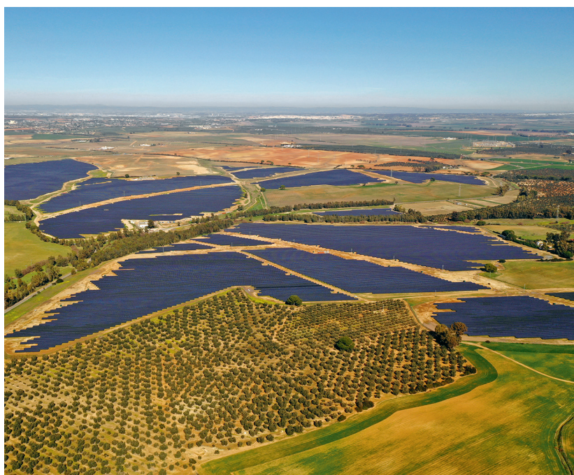
Solarpark in Südspanien: Die Anlage besteht aus 500 000 Solarmodulen
